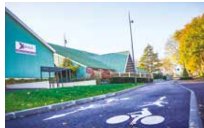
Nouvelle voie d'accès et nouvel espace de stationnement, création d'une piste cyclable et d'une salle de boxe dans l'ancien DOJO : le COSEC Saint-Julien s'est refait une beauté!
