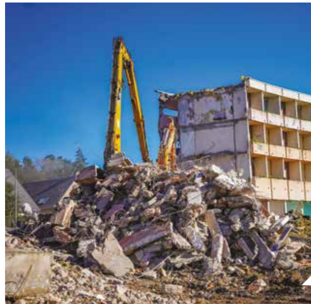
Démolition de la résidence Bellevue L'ancienne maison de retraite laissera bientôt place à quatre bâtiments regroupant 90 appartements.
